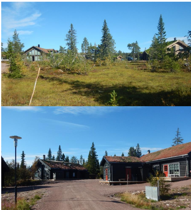
Några av befintliga hus i planområdet.
