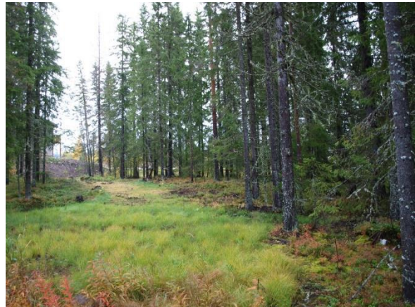
Grävning för rörledning genom området
