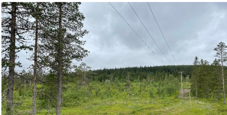
Kraftledning som går parallellt med planområdets norra gräns.
