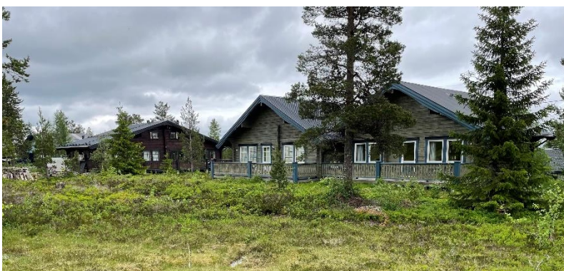
Foto över befintlig bebyggelse längs Fingersvampvägen.
