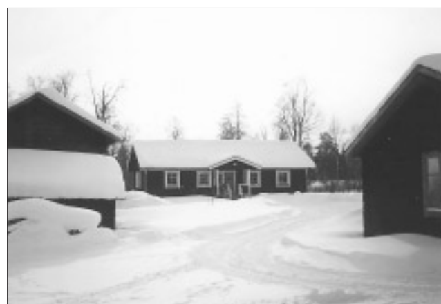
Nybyggnad i anslutning till äldre hus
